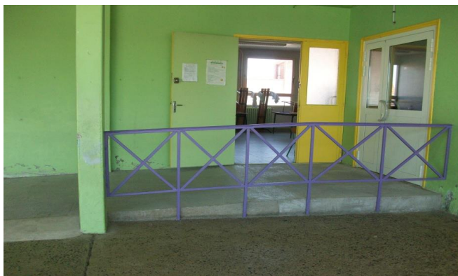
La rampe d'accès réalisée entre l'école, le préau et les anciens locaux de la cantine scolaire.
